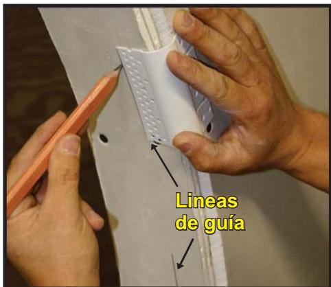
Empiece cortando una pieza pequeña del Bullnose No-Notch Arch como se indica a la izquierda. Use esta pieza para marcar líneas de guía a lo largo del arco. Las líneas de guía son usadas para asegurar una instalación derecha. Asegúrese que las extremidades están alineadas correctamente y no abiertas como se ven a la derecha.
